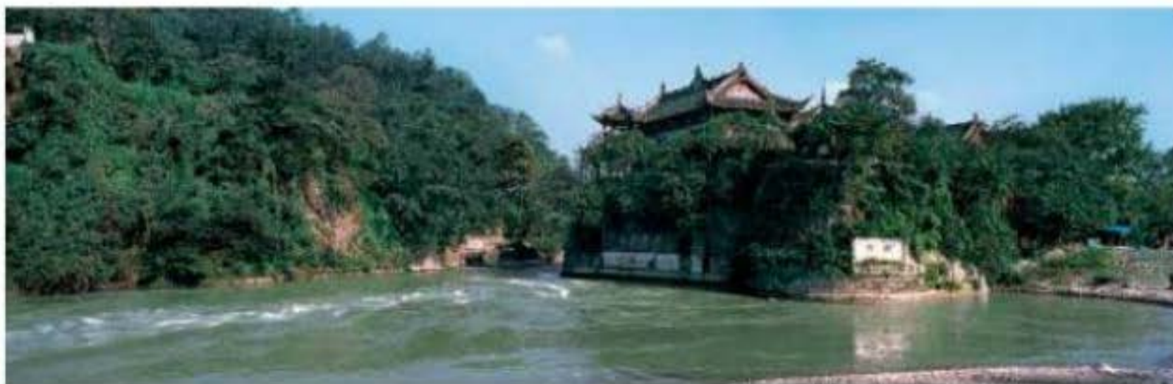
Cửa Bảo Bình ở Đập Giang Đô là dòng chảy do con người đào núi khơi dòng, nước từ Mãn Giang được chảy dẫn vào Nạp Giang, dùng để tưới tiêu đồng ruộng.
