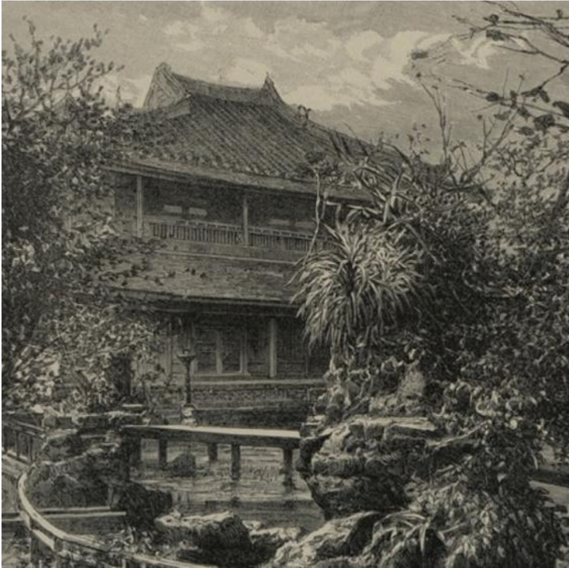
(Ảnh: Biệt điện của nhà vua)
