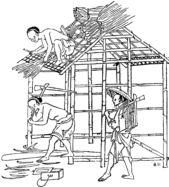
Hình 36 - Thợ lợp nhà và thợ mộc
